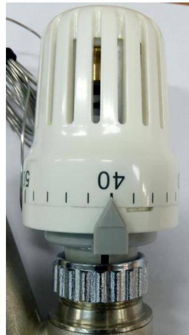
6.4. При промывке стояка рециркуляции необходимо выставить термоэлемент клапана в максимальное положение (дополнительная риска после 60 °C)
