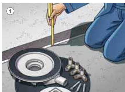
1 Измерить высоту напольной конструкции, здесь: 85 мм.
