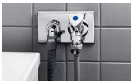
Сифоны с встроенным патрубком подачи воды
