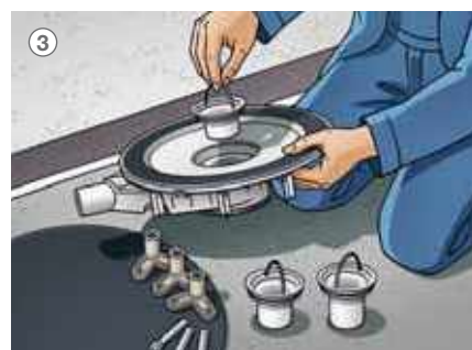
3 Выбрать одну из трех погружных труб, входящих в комплект поставки, здесь используется самый короткий вариант.
